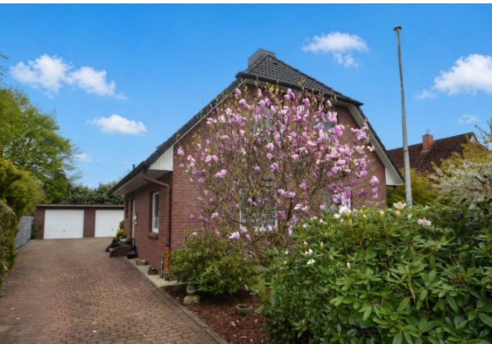
Haus und Garagen
