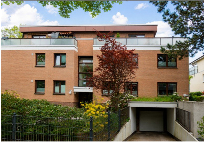
Zufahrt zur Tiefgarage
